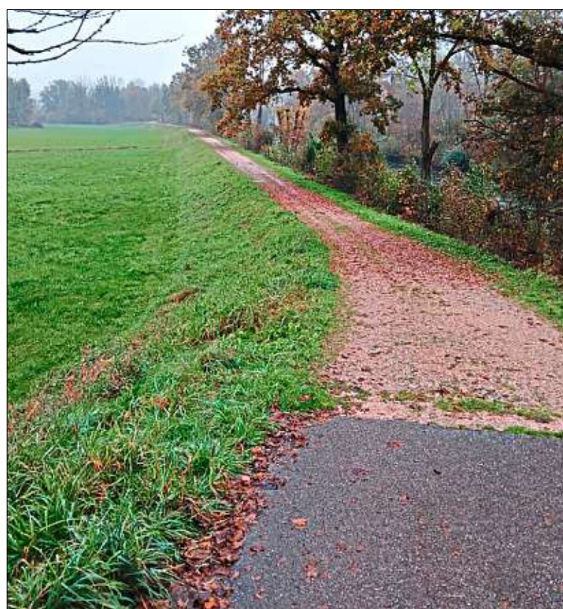
Die Gewissheit, dass er bei einem 100-jährigen Hochwasser hält, vermisst der Arbeitskreis Grund/Hochwasser: Der Damm zwischen Wajoner und Feichtner Brücke.
