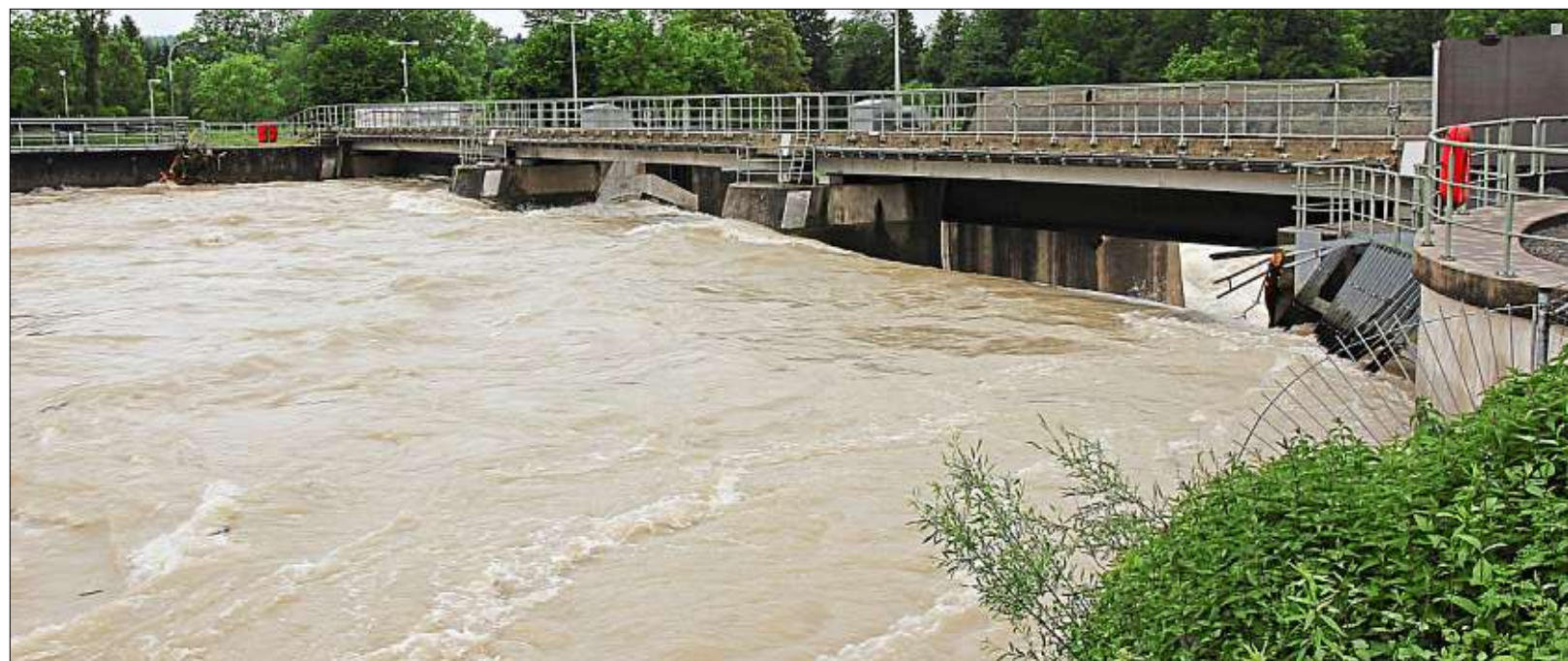
Die Steuerung des Alzkraftwerks an der Feichtner Brücke – hier beim Hochwasser vor elf Jahren – hat laut der DHI-Studie weniger Einfluss auf den Grundwasserpegel als gedacht. – Fotos: Herbert Reichgruber/IG (2)
