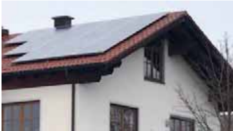
Bild 2: Erste EEG PV-Anlage in Tacherting, 08.Mai 2000 [2].
