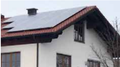
Bild 2: Erste EEG PV-Anlage in Tacherting, 08.Mai 2000 [2].
