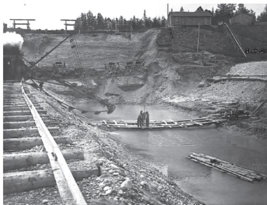
1909 Aushub für Fundamente des Kraftwerks
