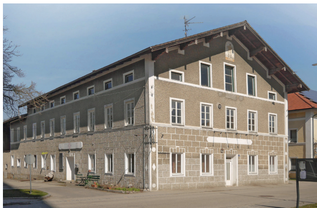
Abb. 84: Denkmalgeschütztes Gebäude | Tachertinger Straße
