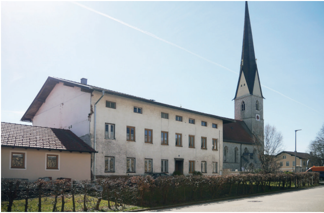
Abb. 90: Erhaltens- und Gestaltungsmängel | Tachertinger Straße
