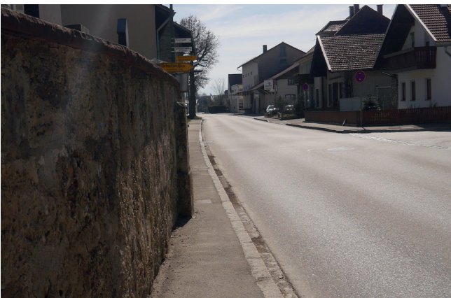
Abb. 91: Unattraktive & gefährliche Fußwegeverbindung | Trostberger Straße
